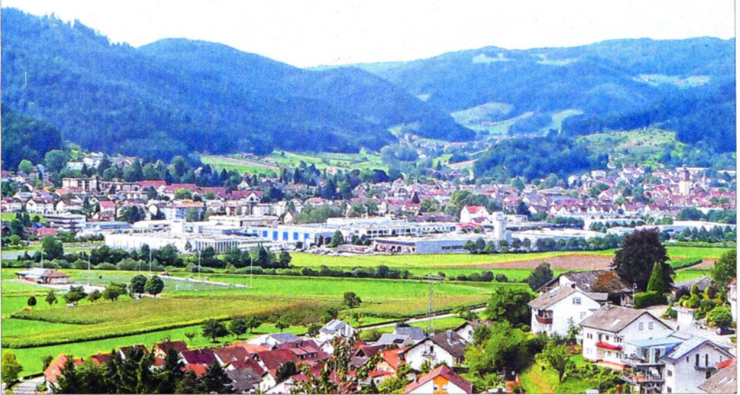
Blick aufs Haslacher Gewerbegebiet Mühlegrün vom Fischerbacher Kirchberg aus. Ohne Troglösung würde von hier aus Haslach hinter einer massiven Brücke verschwinden.
